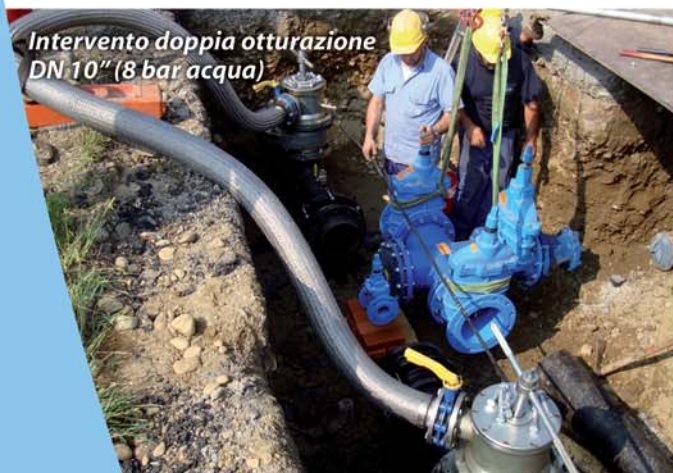
Intervento doppia otturazione DN 10" gas
